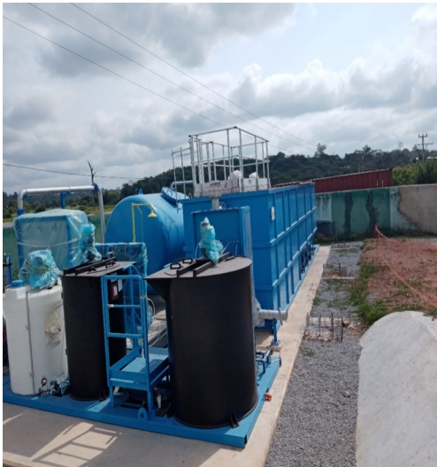
UCD Daoukro réalisé à 97% château d'eau de 1000 m3 sur 30 m.
